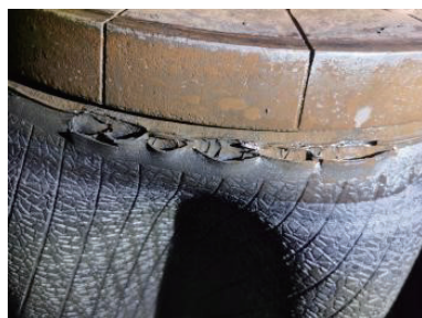
图10 夹环周向零散裂口
