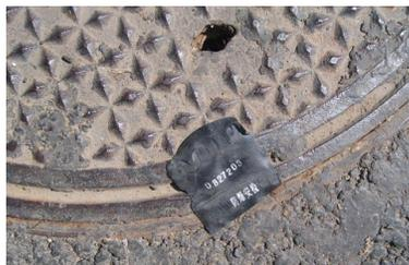
图3 防爆安检用地井井盖橡胶封条应用实例二
