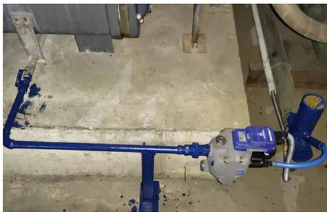
图7 冷凝液自动排除器
