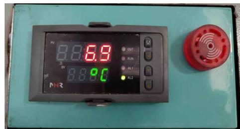
图12 压缩空气露点控制面板
