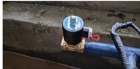
图10 定时排水电磁阀
