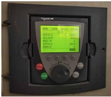
图5 空压机变频器控制面板
