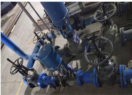
图1 高压空气管道与中压空气管道之间的调节阀
