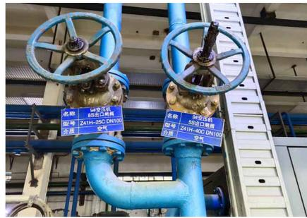
图2 中压空压机出口管道
