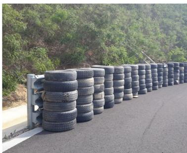
图2 三W板护栏和轮胎墙
